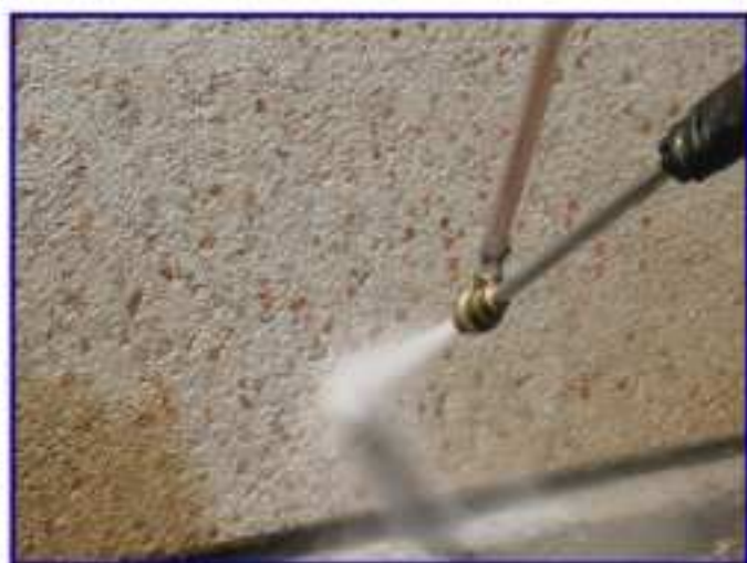
Pulizia e Sabbatura Facciate
